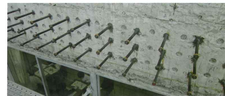
ブラストキー工法による施工事例
