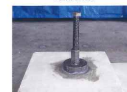
接続ボルト取り付け
